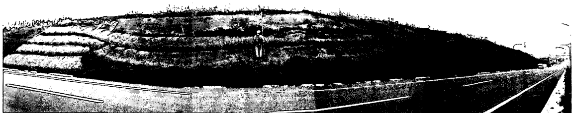
写真 9.3.7 海側切土のり面の崩壊 (正面から撮影)
