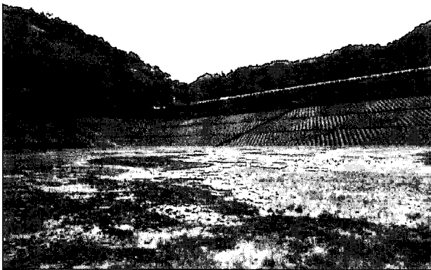
写真 8.13 三石ダムの上流面
