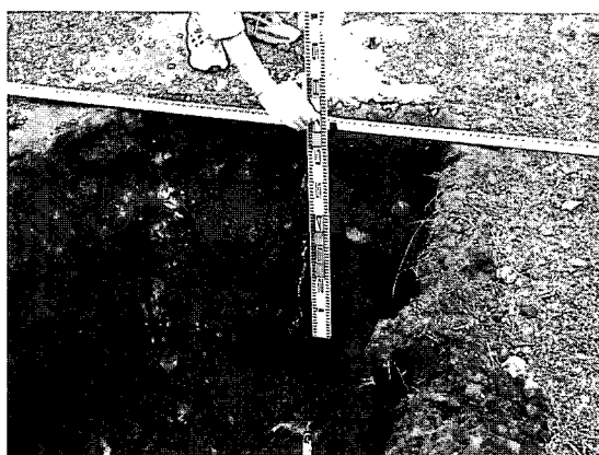
写真 8.10 ピット試掘によるクラック深度調査 (高見ダム)
