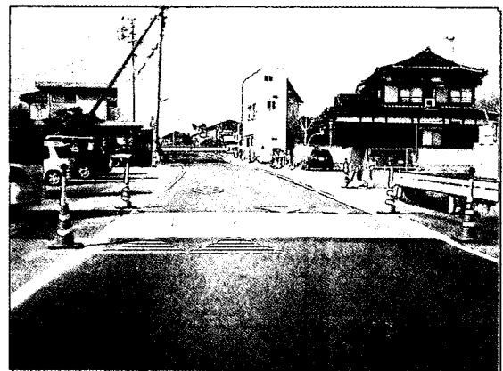
写真-1 ハンプ設置状況
