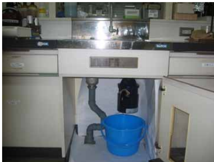
写真 3.2.1 厨芥の水質転換率調査の状況（ディスポーザーの設置状況） 8)
