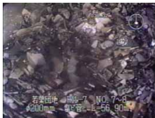
写真 4.2.3 ディスポーザー設置地区の管渠内堆積物の状況（歌登町） 11)
