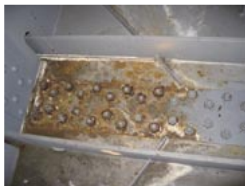
写真-20.3 箱桁内部の排水枓からの漏水により，箱桁内部の滞水と鋼材の腐食が生じた例
