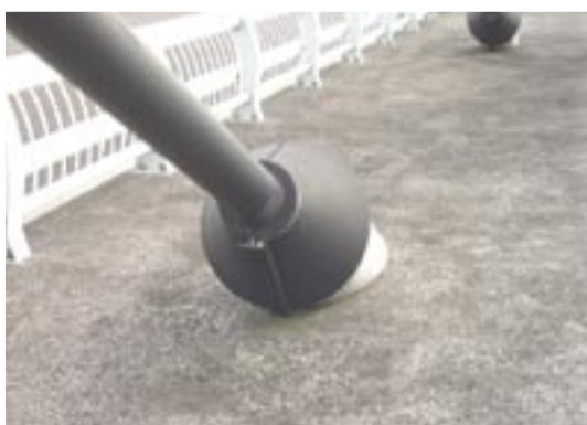
写真-18.3 斜張橋の定着部の例 (注：健全な状態)
