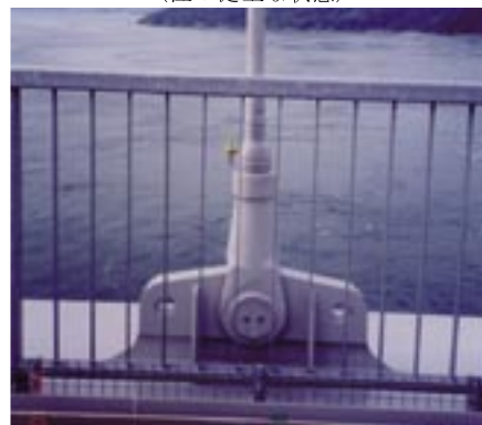
写真-18.6 吊り橋のハンガ一定着部の例 (注：健全な状態)
