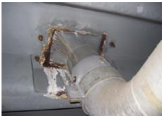
写真-20.3 箱桁内部の排水枓からの漏水により，箱桁内部の滞水と鋼材の腐食が生じた例
