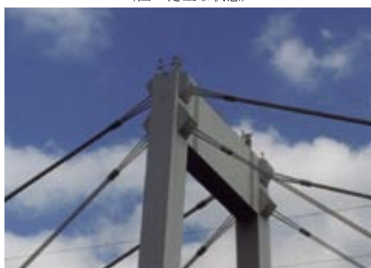
写真-18.5 斜張橋の定着部の例 (注：健全な状態)
