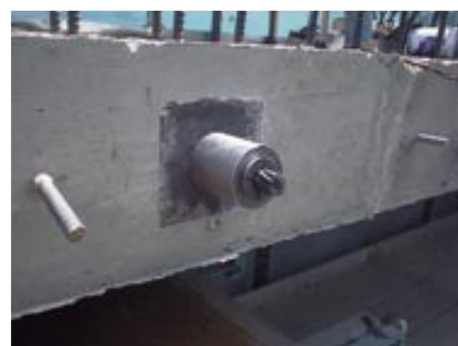
写真-18.10 PC横締め定着具の例 (注：施工時の健全な状態)
