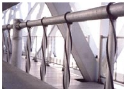
写真-21.4 振動防止対策されている防護柵
