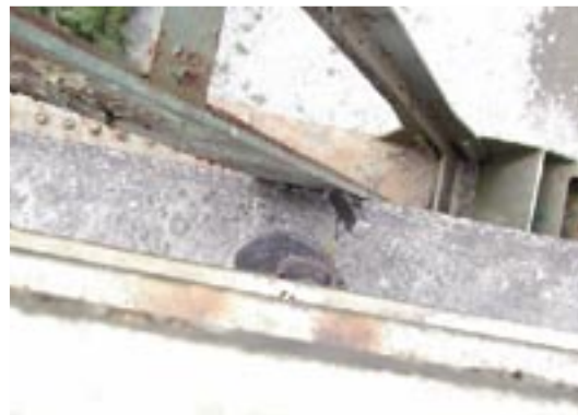
写真-21.2 トラスの余材とRC床版が干渉して異常な音を生じた例
