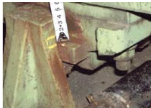
写真-14.7 伸縮継手部の段差と支承ローラーの脱落が原因で生じた例
