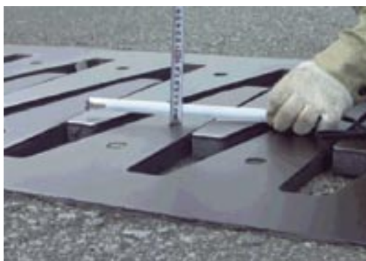
写真-14.7 伸縮継手部の段差と支承ローラーの脱落が原因で生じた例
