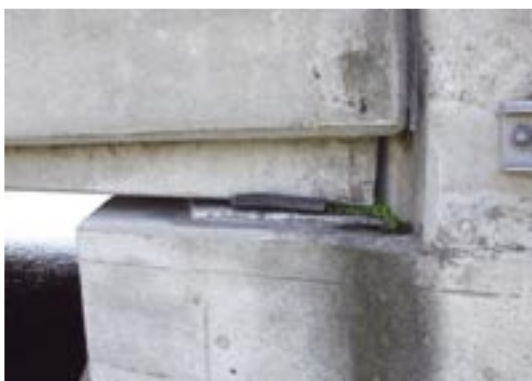
写真-16.5 変位追随機能と荷重支持機能が著しく阻害されている可能性がある状態の例
