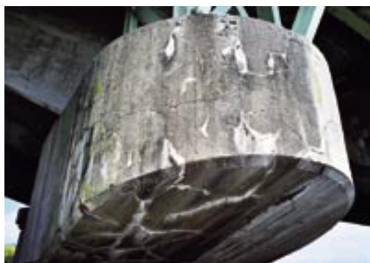
写真-8.6 T型橋脚のひびわれ部から生じた例
