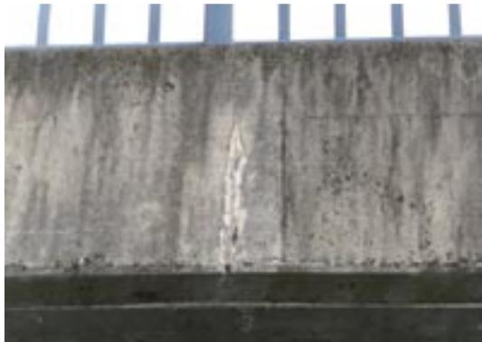
写真-8.1 車両用防護柵のひびわれ部から生じた例
