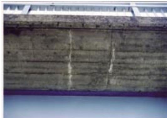
写真-8.9 ひびわれ部から生じた例
