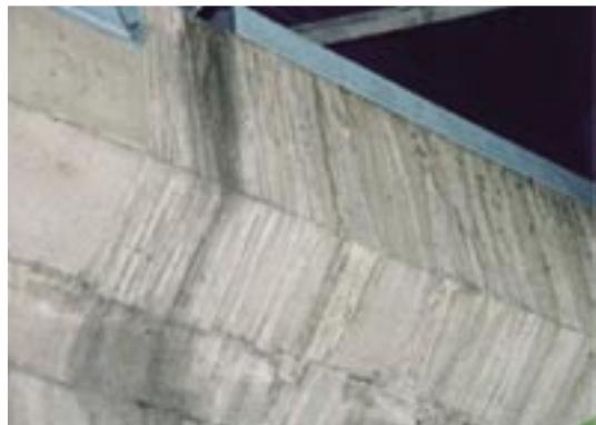
写真-8.8 表面を伝う水によって析出物が発生した例
