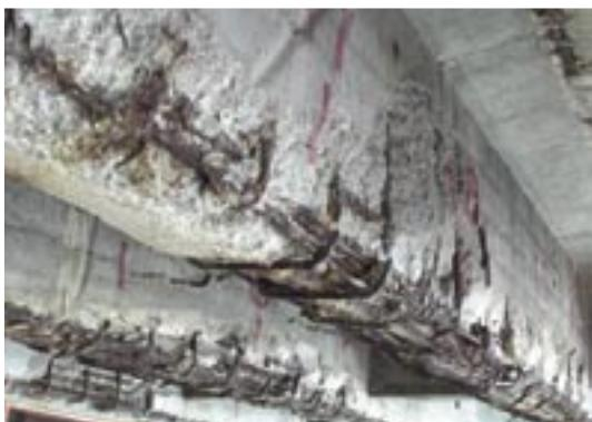
写真-7.9 露出した鉄筋が腐食、破断している例
