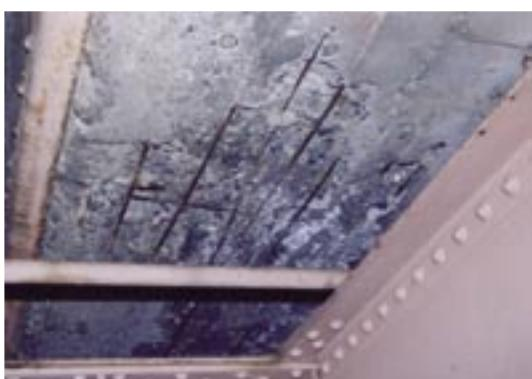
写真-7.11 床版に剥離・鉄筋露出を生じた例
