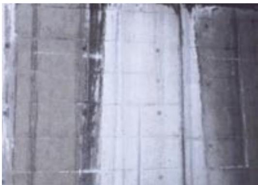
写真-8.7 表面を伝う水によって析出物が発生した例
