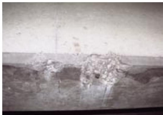
写真-7.8 欠損(衝突痕)を生じた例
