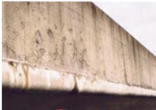
写真-8.2 張出し床版と地覆の打継目から生じた例
