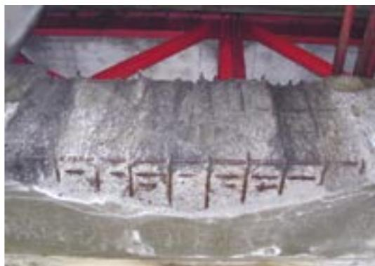
写真-7.10 露出した鉄筋が腐食している例
