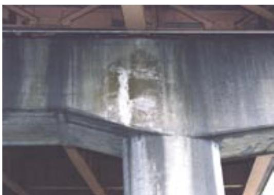
写真-8.5 ラーメン橋脚のひびわれ部から生じた例
