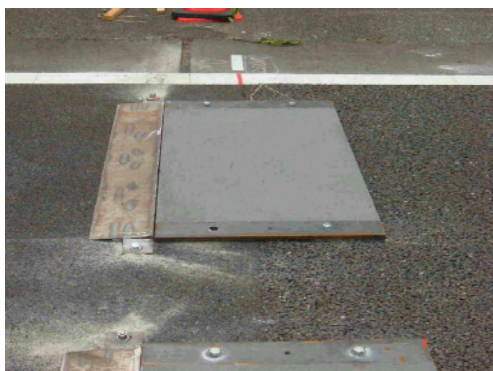
(a)斜路つき段差
