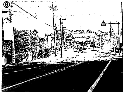
当該交差点の国道A100m東側に信号交差点がある。
