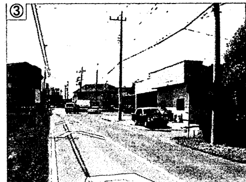
③ 県道Aの東方向からの進入は、本線のカーブ途中に交差点があり、直線道路と錯覚を起こしてしまう(スピード超過ぎみに進入)。
