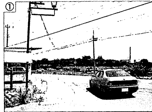
① 県道Aの北西からの進入では、カーブ内側の路外施設により見通し悪い。
