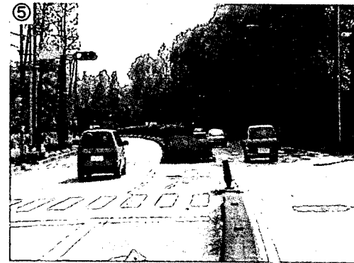
⑤ 国道Aに右折専用車線はあるが、右折専用現示なし。対向直進車青現示で右折する必要がある。カーブと中央帯の植栽により、対向車線の見通し悪い。
