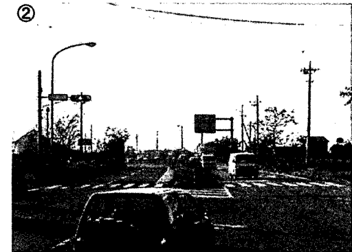
② カーブと中央分離帯の植栽により、国道A東側流入部の右折車線から対向直進車の見通し悪い。
