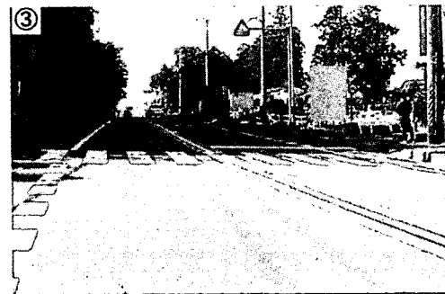
③ 国道A停止線位置からの視点。 前方にクレストはあるが、見通し距離は確保されている。
