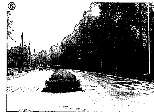
⑥ 停止線からでも分離帯の植栽により北進車を確認しにくい。
