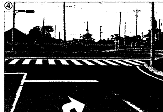
市道Bからの右折車線から、対向車線は折れあし状に取り付いているが遮蔽物が少ないため比較的見通しよい。
