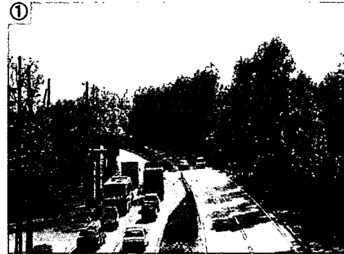
① 国道A北側から南側の状況 (近隣OVより)。
