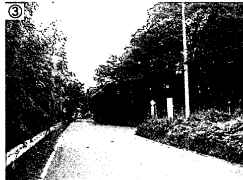
③ 県道Aを北進する車は、クレストのため当該三叉路が直前まで確認できないにも関わらず、速度を超過する車両が多い。また、大型車の交通量も非常に多い。
