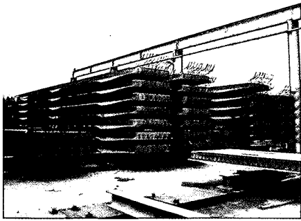
写真-4.2.1 保管状況
