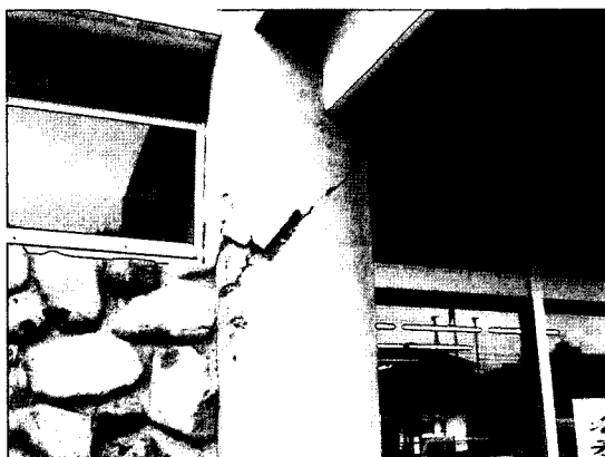
写真 10.5 玄関脇の柱のせん断ひび割れ
