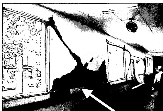
写真 10.7 旧校舎1階廊下の方立壁の被害
