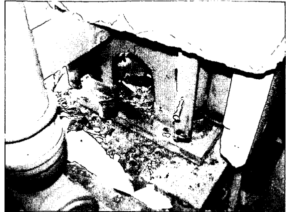
写真 10.18 塔屋の基礎アンカーの破断
