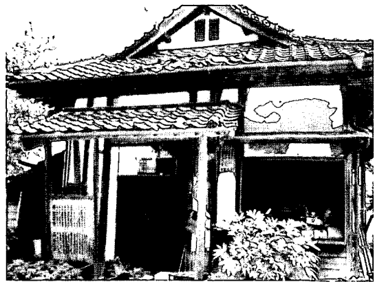
写真 10.12 木造平屋建て外壁の被害
