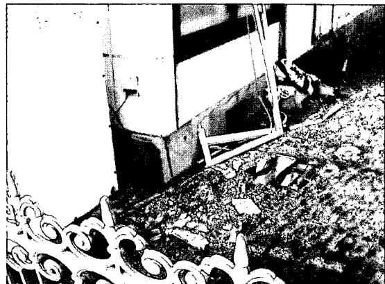
写真 10.14 軽量鉄骨プレハブ住宅の被害
