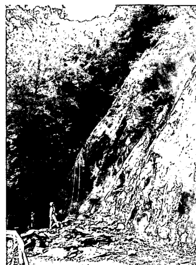
写真8.5 甲子町(その1)地区 落石状況
