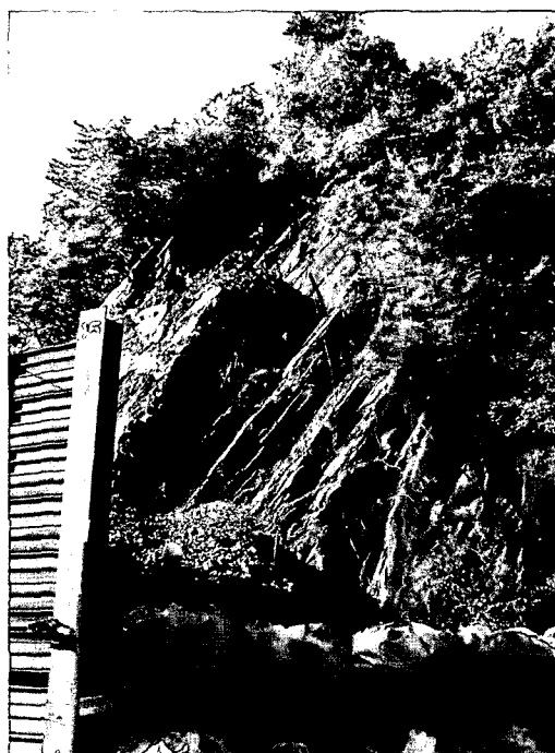
写真8.4 世田米子飼沢地区 落石状況
