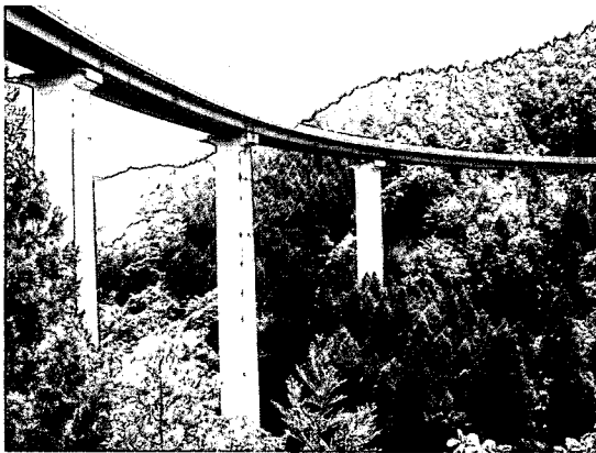
写真 7.19 国道343号笹の田大橋 (岩手県大東町、ハイピア50m程度、ループ橋)
