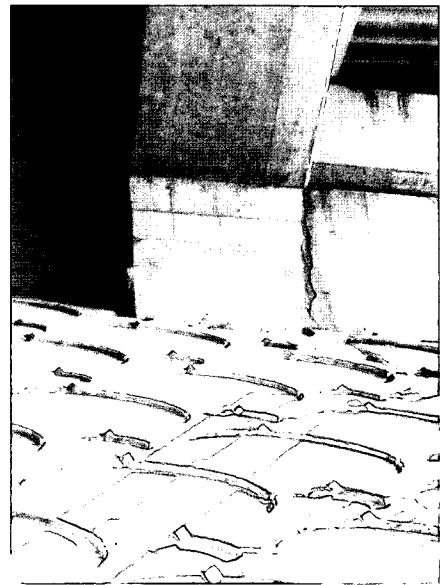
写真7.3 国道45号白木沢橋(岩手県大船渡市三陸町吉浜、橋台部の本橋と添架歩道部のコンクリート継目のひびわれ、変色のため地震以外の影響の可能性もあり、構造的な影響はないと推定)
