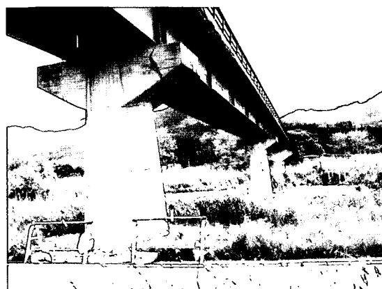
写真7.6 村道船渡線船渡橋 (RC橋脚)
