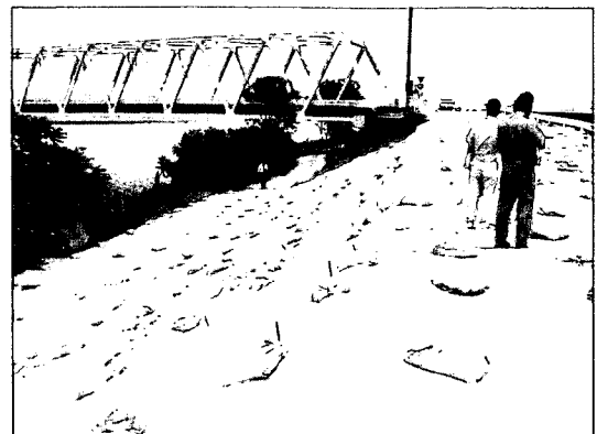
写真5.8 調査時の新北上大橋右岸上流の堤防(北上川右岸3.8k)
