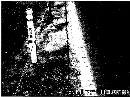
写真5.9 被災直後の月浜地区、天端腹付け部との境界にクラック(北上川左岸2.2k)
