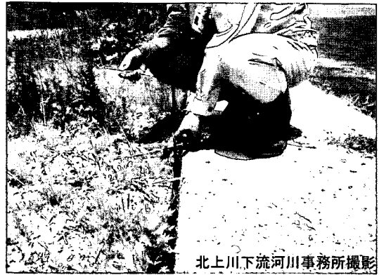
写真5.10 被災直後の月浜地区、低水護岸と背後の地盤に間隙(北上川左岸2.2k)
