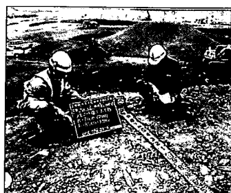
現行：巻き尺による出来形の計測
