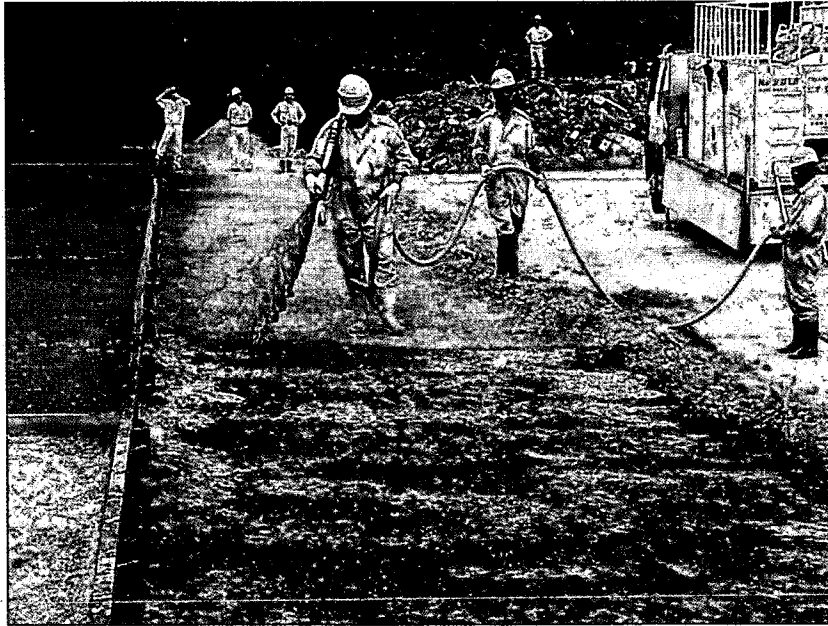
写真-11 セル苗吹き付け状況
