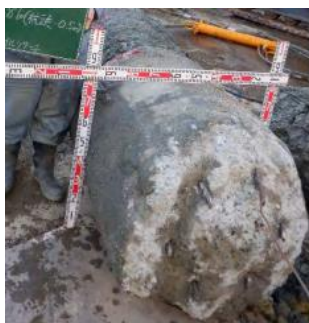
(a) 杭径測定
