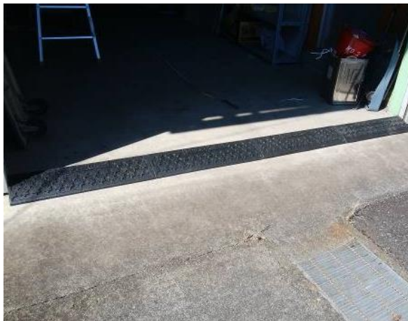
図 2.4.26 車両保管場所入口の段差解消 (C 団地)
