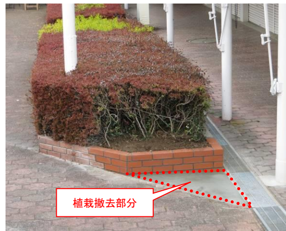
図 2.4.27 動線確保のための車両保管場所 出入口部分の植栽の一部撤去 (A 団地)
