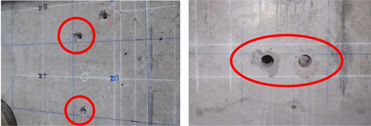
写真3.7.1 あと施工アンカーやボルト貫通用の開孔と壁筋位置の近接
