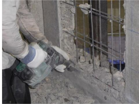
(b) 新設開口部分のコンクリートのはつり出し
