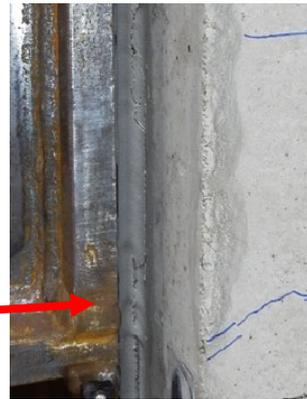
(直交壁—壁板間の損傷)
