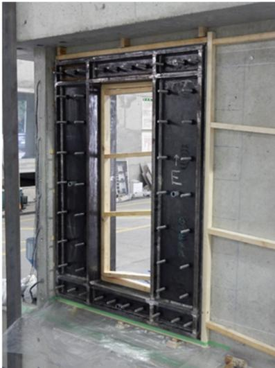
写真 5①-a 型枠の設置
