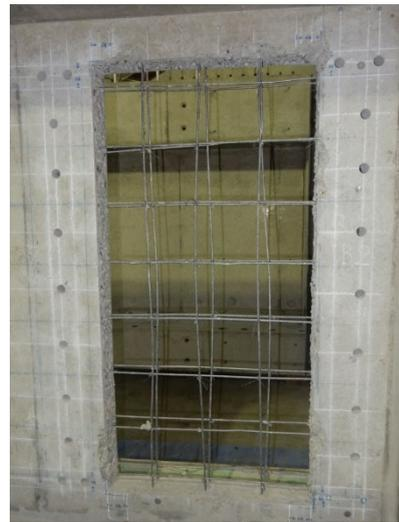
写真1-b はつり工事後の完了後
