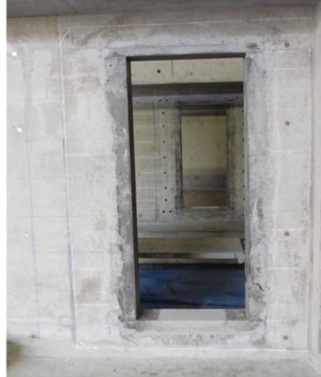
写真 3-b コンクリートは、棒状バイブレーターおよび外振型バイブレーターにより十分に締め固めを行います。型枠の脱型は所要の材齢が経過後に行い、コンクリートに損傷が生じないように注意します。
