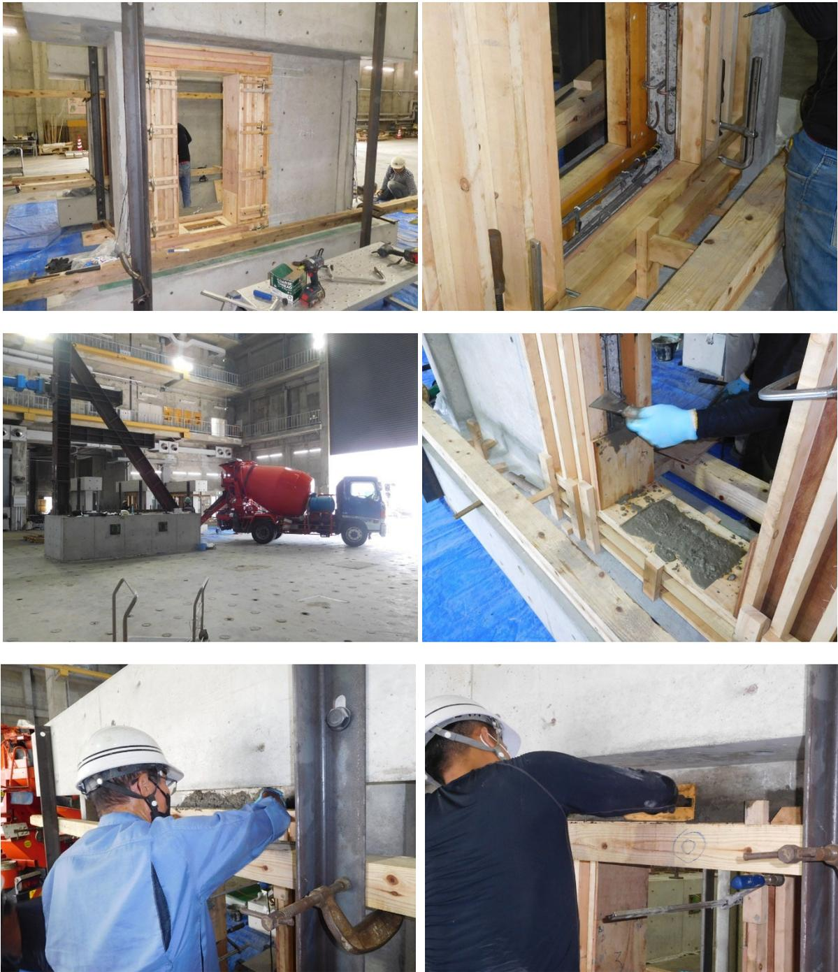
写真3.6.1 コンクリート打設工事
