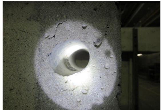
(f) 途中で削孔をやり直した開孔の内部の様子
