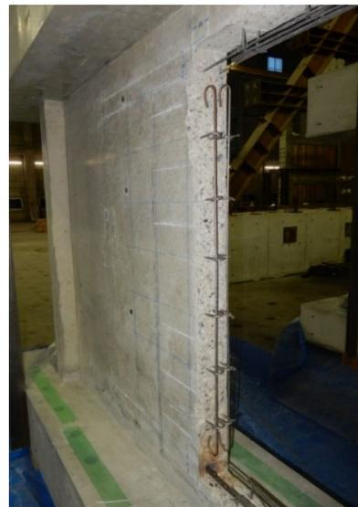
写真2-b 配筋工事後の完了
