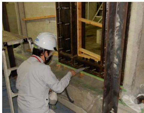
(f) 開口補強試験体 WOB の無収縮モルタル充填
