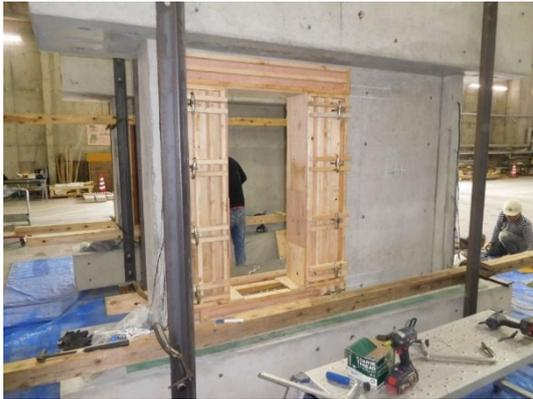
写真 3-a 型枠の設置。型枠には確認孔を設けて、コンクリートの充填状況を確認できるようにします。
