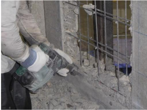
写真1-a コンクリートのはつり出しは、壁板の両面から周囲にカッター等で切り込みを付けてから行い、周辺の残存部分のコンクリートにひび割れ等の損傷を与えないように十分に注意します。
