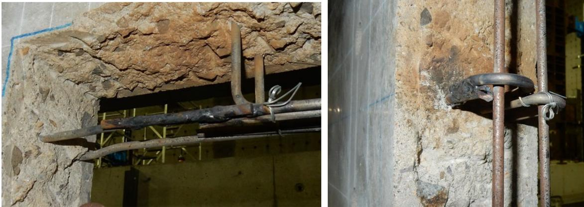
写真3.5.2 配筋工事における損傷した鉄筋の補修
