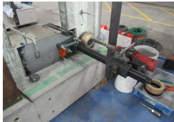
(d) あと施工アンカーを用いない開孔方法
