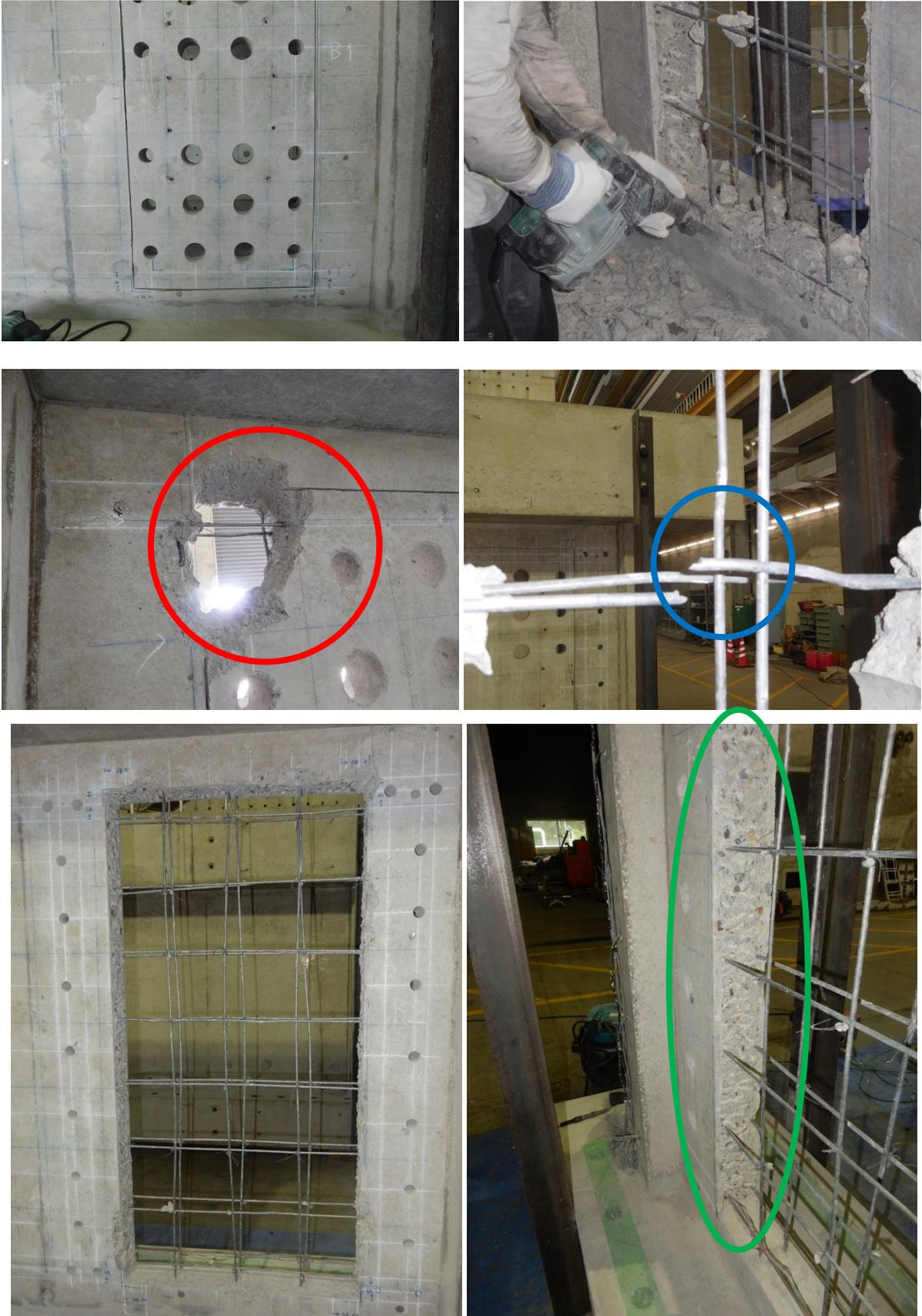
写真3.4.1 コンクリートのはつり工事
