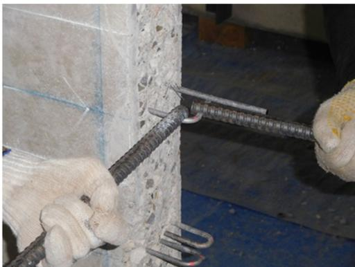
写真2-a 壁配筋の90°折り曲げによる定着長の確保と壁横筋端部への180°フックの設置
