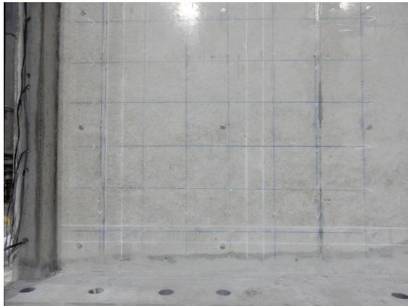
写真3. 2. 1 鉄筋探査の様子（左写真の青線が鉄筋の位置）
