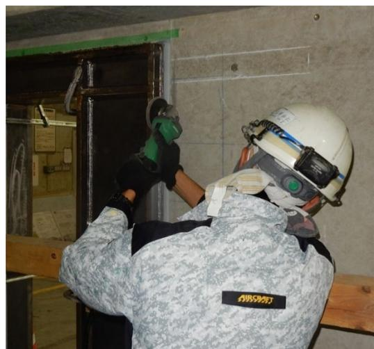
(g) シール材の塗布（上面）、アルミパイプの切断
