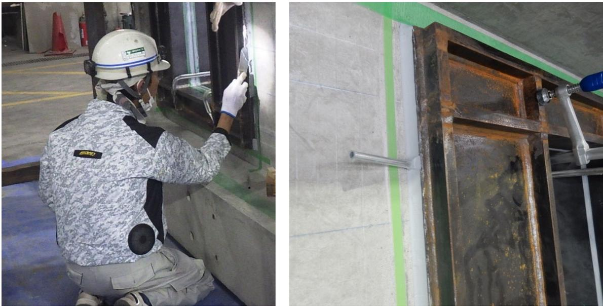
(b) シール材の塗布（頂部を除く外周部、内周部）、アルミパイプの設置（外周部のみ）
