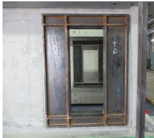
写真 5② エポキシ樹脂の充填による接着接合完了後
