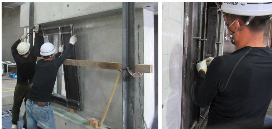
写真3.9.3 鉄骨枠の取り付け状況
