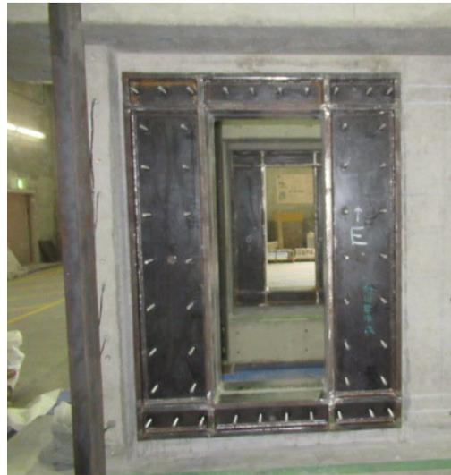
写真 5①-b 無収縮モルタルの充填による接合完了後
