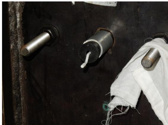
(a) 無収縮モルタル試験片の採取 (b) 無収縮モルタルの充填状況の確認
