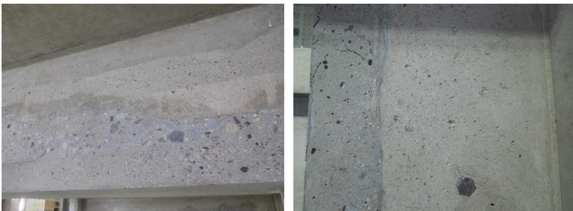
写真3.8.1 壁板における接合面の処理
