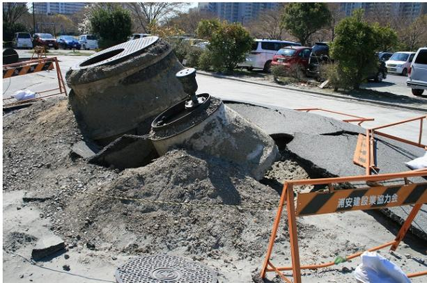
写真-3.3.12.4 液状化による貯水槽の浮上（浦安市）
