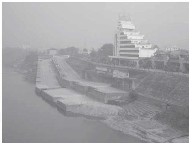
写真 A3-2 景洪港
