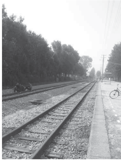
写真 A2-7 中国側鉄道線路（昆明—河口間の建水市内で撮影，軌間 1m，現在定期列車は運行されていない）
