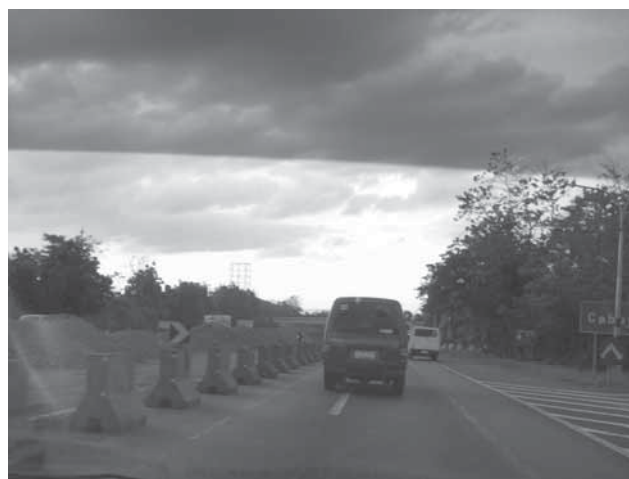
写真 A11-1 マニラ～カランバ間の高速道路 （補修区間）
