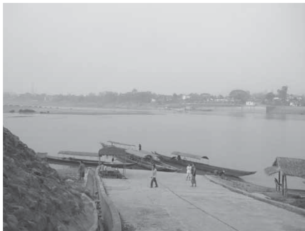
写真 A5-2 国境渡船場の状況 （1：ラオス側よりタイ側を望む）
