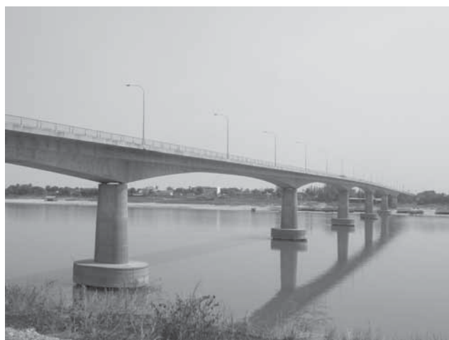
写真 A4-2 タイ・ラオス友好橋
