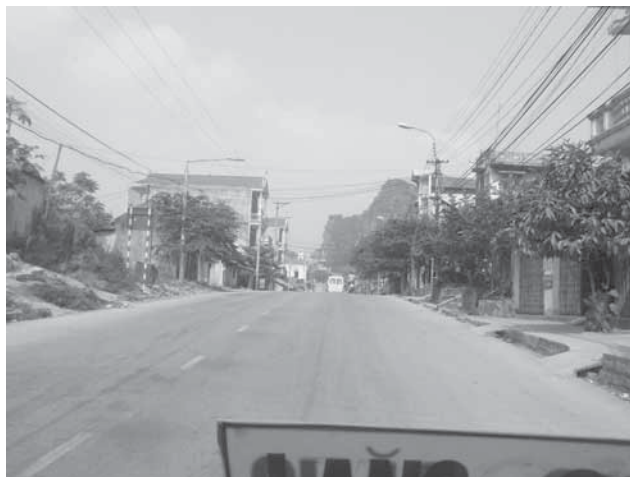
写真 A1-1 ベトナム側の幹線道路
