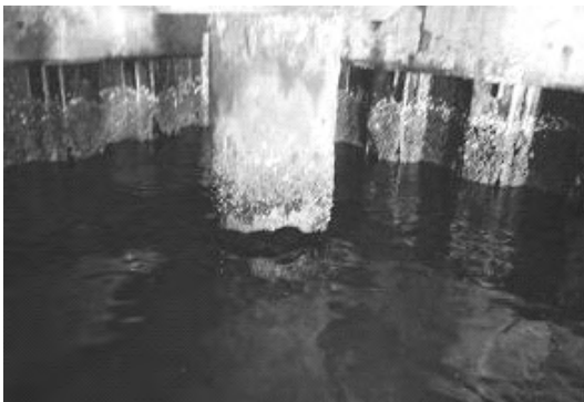
図 2-9 下部工 鋼管杭の劣化状況
