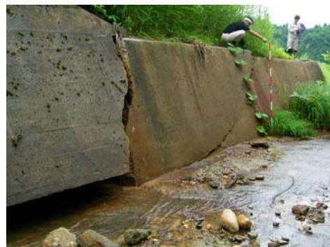
写真-4.19 砂防えん堤側壁の変状
