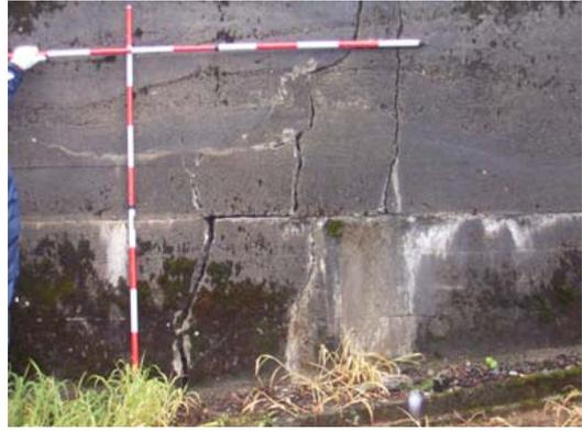
写真-4.12 堤体にクラックが生じた事例
