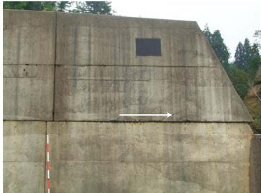
写真-4.13 打継目にずれが生じた事例
