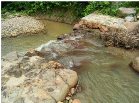
写真-4.18 床固工水通し天端の変状
