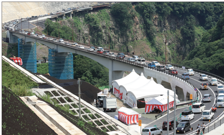
写真 平成 29 年 8 月に開通した南阿蘇村の道路橋
