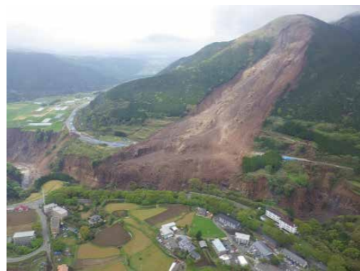
写真2 阿蘇大橋付近の大規模な斜面崩壊
