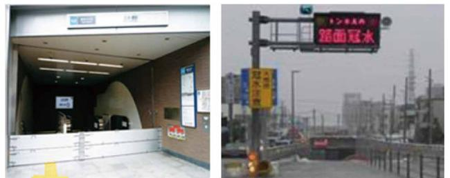
写真 浸水対策(左は止水版の設置、右は道路冠水情報)
