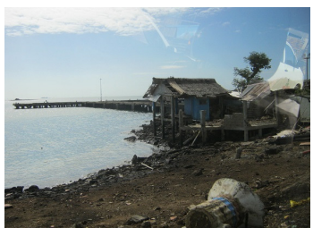
写真 エスタンシア港の被災状況
