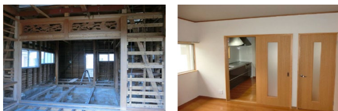
写真-1 A 邸 1 階の改修工事の様子と改修後
