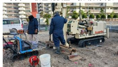
写真-2 杭撤去後の地盤でのCPT試験状況(福岡市)
