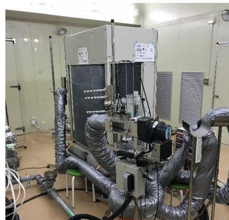
図-1 負荷固定試験の様子 (室外機)
