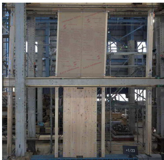
写真 1 CLT+枠組壁工法の立面併用構造の施工実験
