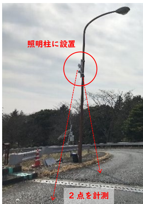
図2 路面変状検知システム(無線センサ)の設置状況
