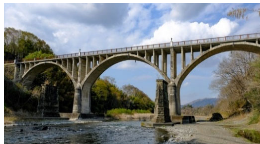
写真-2 試行対象 コンクリート上路アーチ橋
