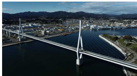
写真-1 試行対象 斜張橋
