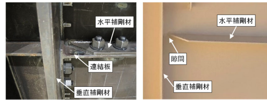
図-5 連結部状況
