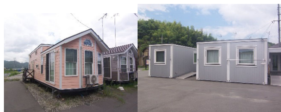
図-1 トレーラーハウス(左)とコンテナハウス(右)
