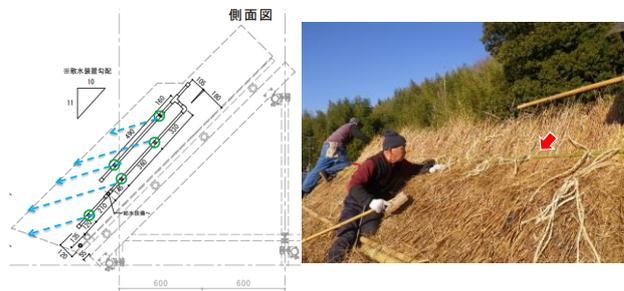
図-2 散水設備を組込んだ試験体と伝統工法の押し鉾
