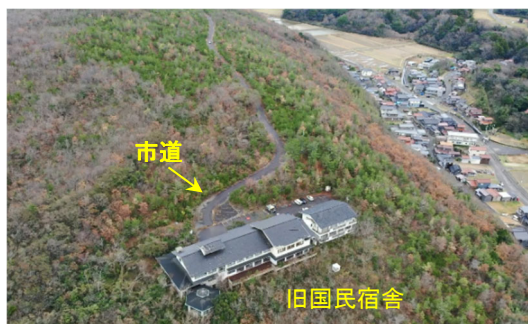
図-1 現場飛行実験場所（片野町市道）
