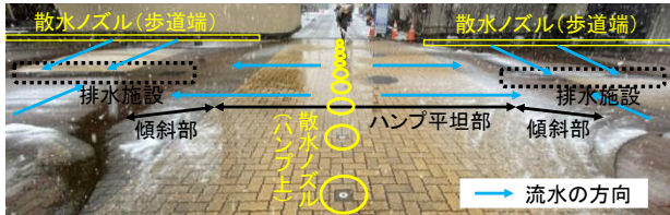
図-1 消雪パイプの設置事例
