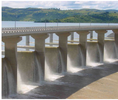
(a) フィルダム非常用洪水吐にラビリス堰を設置 2)
