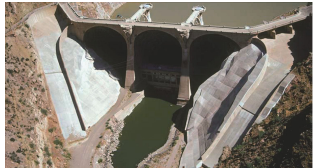
図-1 局部改良の事例(米国 Coolidge dam) 1)
