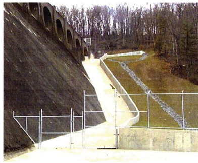
(b) 重力式コンクリートダム堤体下流に導流壁・シュート部を設置 3)
