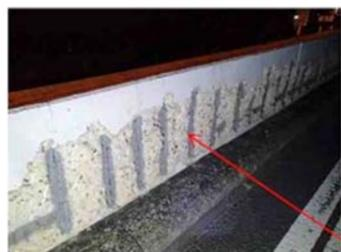
写真③-3 断面修復完了状況 (壁高欄部)
