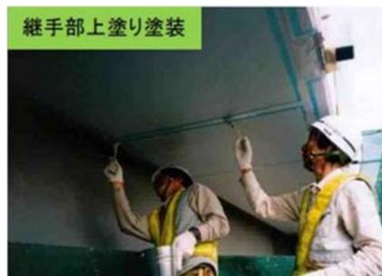
写真⑤-3 継手部の上塗り塗装
