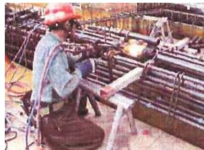
写真⑦-3 主筋ガス圧接状況
