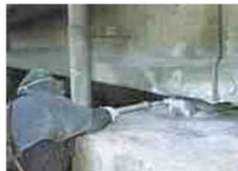
写真⑥-3 垂鉛溶射工
