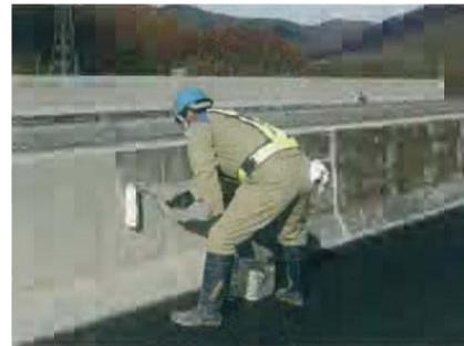
写真④-2 表面保護材塗布状況
