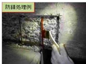
写真③-2 鉄筋防錆材塗布状況
