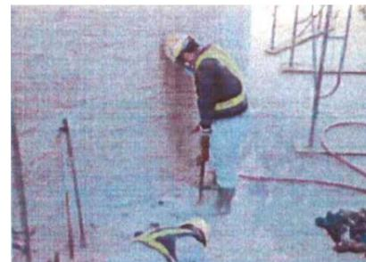
写真⑦-2 コンクリート削孔状況
