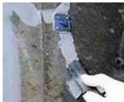
写真①-2 注入後の注入器具取外し状況
