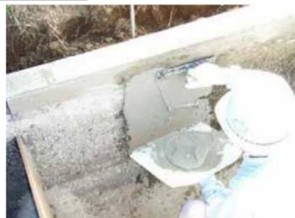
写真④-1 不陸調整工状況
