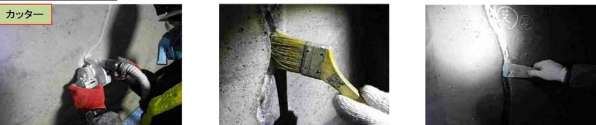
写真②-1 ひび割れUカット状況
