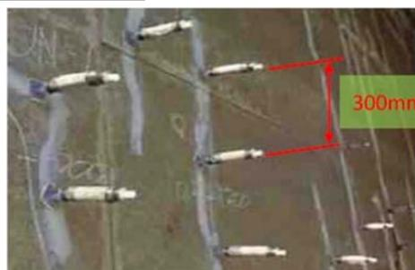
写真①-1 注入器具取付状況
