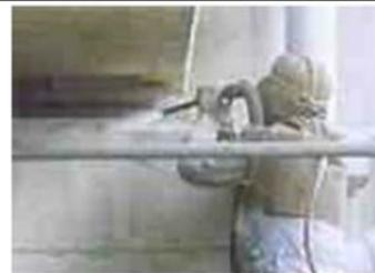
写真⑥-2 素地調整工
