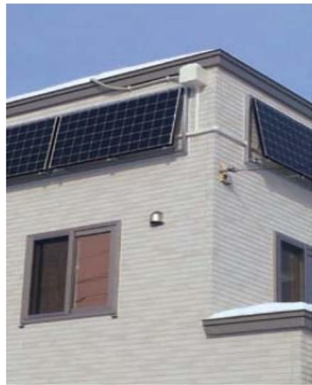
写真 4.3.1-4 壁面設置型・独立型太陽光パネル
