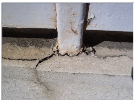
写真Ⅲ.4.1 (左・右) 鋼製手すり支柱の付け根のひび割れや欠損
