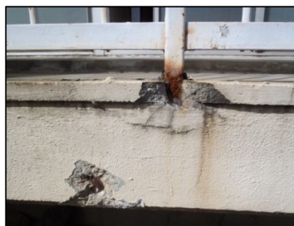
写真Ⅲ.4.1 (左・右) 鋼製手すり支柱の付け根のひび割れや欠損
