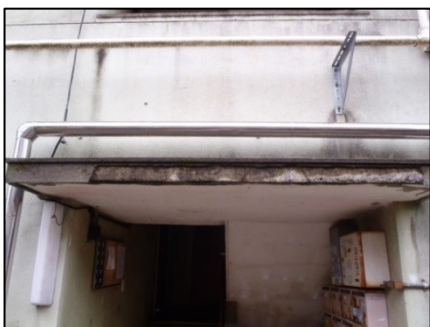
写真Ⅲ.4.2 庇の鼻先のひび割れや欠損
