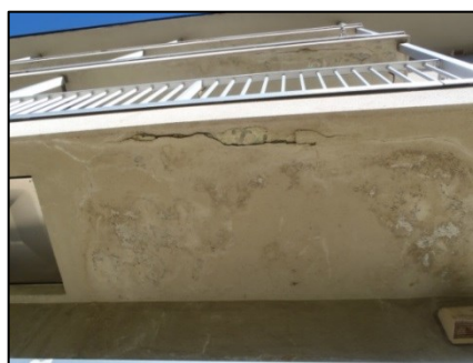
写真Ⅲ.4.3 バルコニー上げ裏天井のひび割れ・浮き
