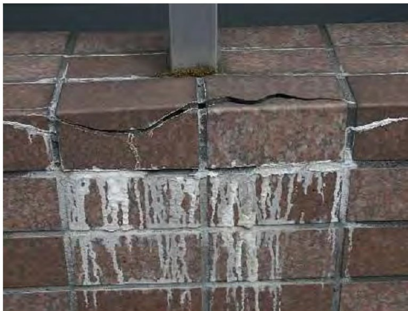
写真Ⅲ.4.5 バルコニー手すり天端タイルの手すり支柱部の凍害破損（建築後 10 年）
