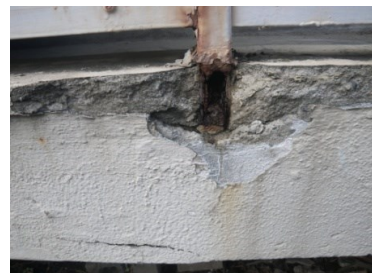
ベランダ手すり下部
