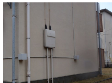
外壁(西面)スイッチボックス周辺
