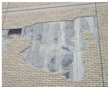
写真6 タイル剥落
