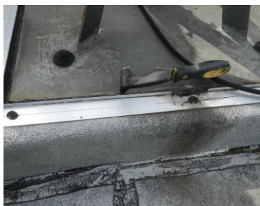
屋根防水・設置物基礎
