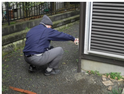
写真 4.8 現況仕様の確認 (基礎高さの計測状況)
