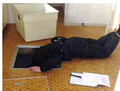
写真 4.14 変状(内部)の確認状況 (床下の確認)
