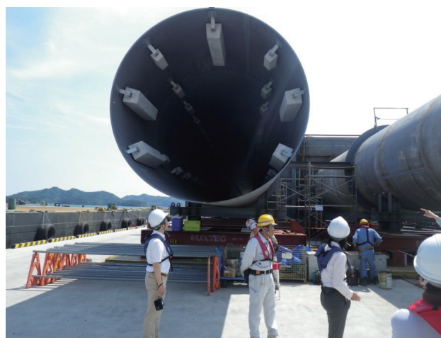
写真-2.1 通水管の外観
