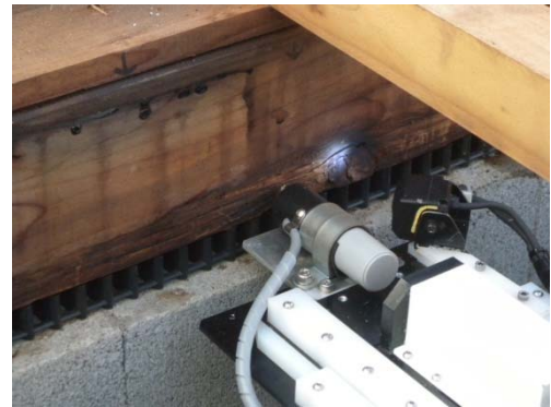
写真 5.9.2(診断状況 2: 含水率測定状況)
