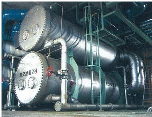
図 2.3.6 シェル&チューブ熱交換機
