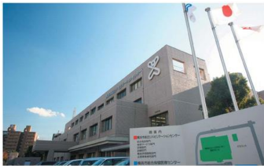
リハビリテーションセンター(12,523 m 2 , 1986 年竣工)
