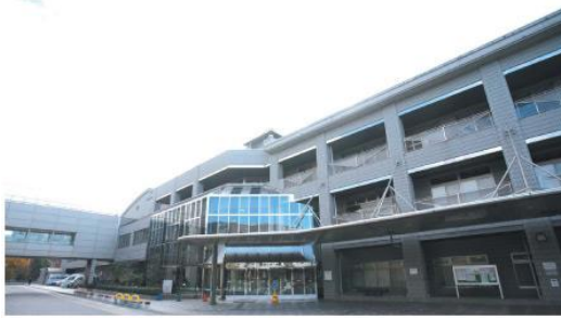
横浜ラポール(14,421 m 2 , 1991 年竣工)
