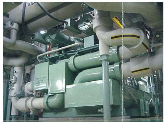
図 2.3.7 熱回収型ヒートポンプ
