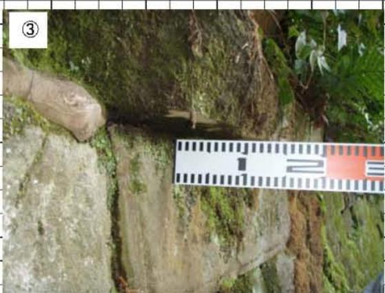
③ 樹木の根系が発達し、擁壁上部のブロックが10cm程度前方にせり出している。
