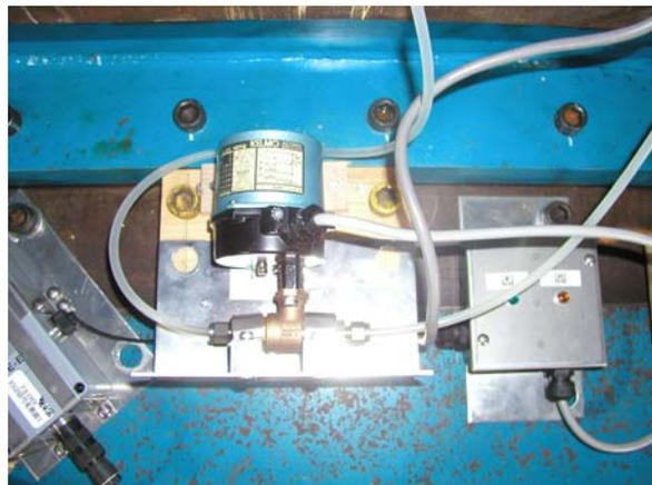
図 3. 15 電動式の排水弁
