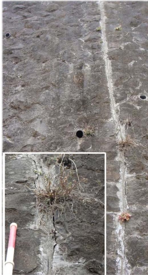
図 2.52 目地の開きの補修跡
