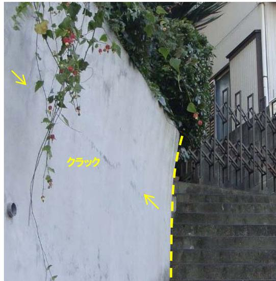
図 2.63 明らかに前傾しているコンクリート擁壁
