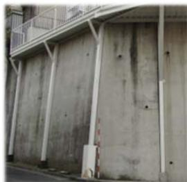
図 2.11 鉄筋コンクリート擁壁
