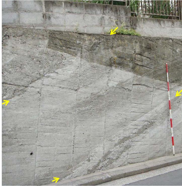
図 2.58 コールドジョイントの認められるコンクリート擁壁
