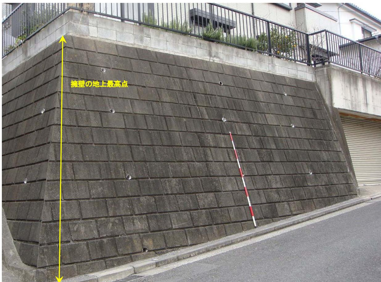
図 2.26 擁壁の地上最高点の計測
