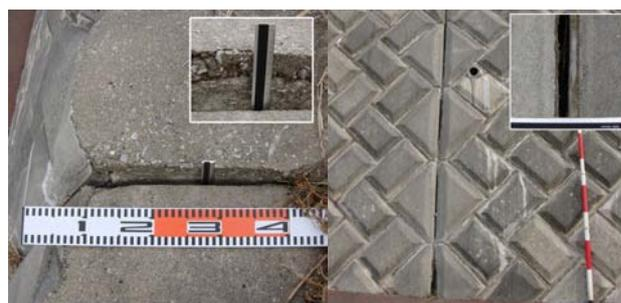
図 2.51 目地の開きの幅の確認
