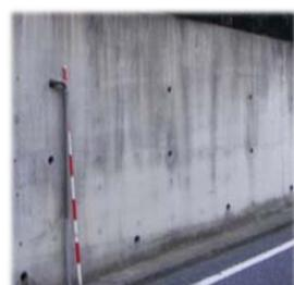
図 2.10 重力式コンクリート擁壁
