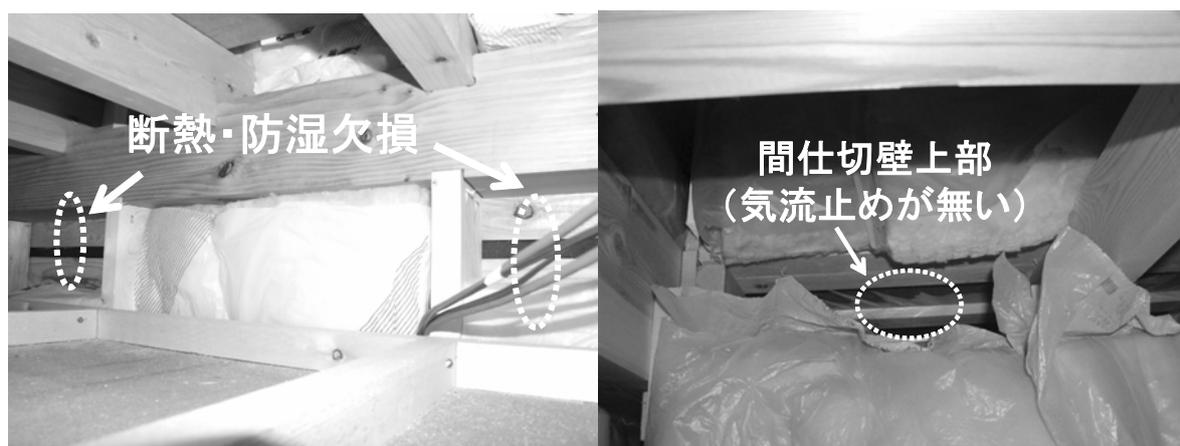
図3.1.2 壁の実況見分の事例
