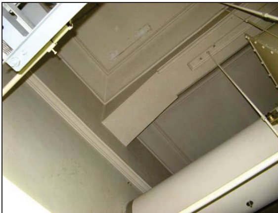
機械室 梁型・廻縁
