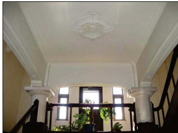
ホール 天井見上げ
