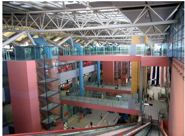
写真-4 吹抜け空間「キャニオン」(関西国際空港, 1994)
