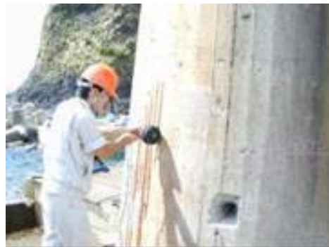
図1-3-3 コンクリート部材の非破壊検査
