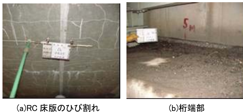
図1-6-4 C橋の状態
