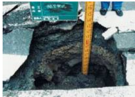
図1-2-3 老朽化した管渠と道路陥没事故 4)
