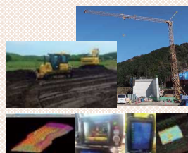
ICT施工・電動建機の例
