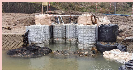
応急復旧した浄水場の取水施設(珠洲市)
