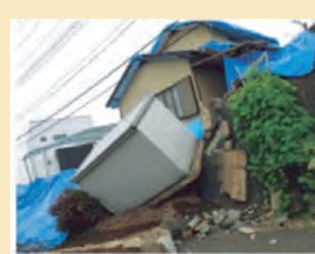
被災した宅地と住宅
