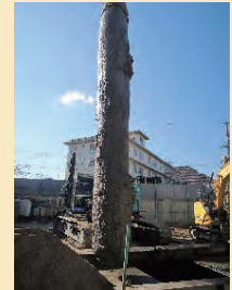
既存杭の撤去工事の状況
