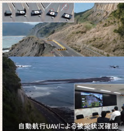
(道路構造物研究部)
