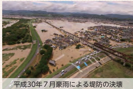
平成30年7月豪雨による堤防の決壊
