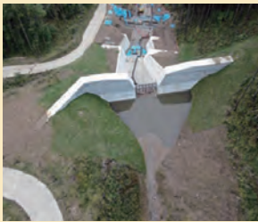
土砂・流木捕捉効果の高い砂防堰堤を整備（長野県須坂市）
